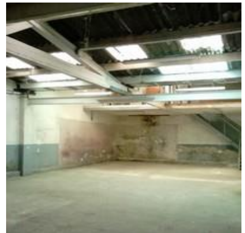
Les locaux de Montety voués à la démolition
